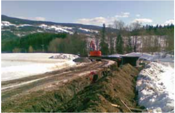
Høyspentlinjen ved Øyar kapell i Vestre Slidre blir lagt i bakken.
